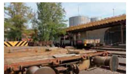
Bau der Hilfsbrücken über das Hafengelände an der Hiltalingerstrasse
