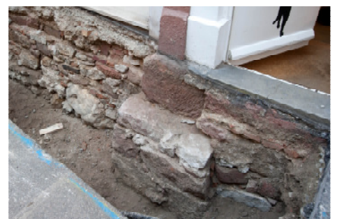
Rest eines barockzeitlichen Stützpfilers, der im Aufgehenden zur Hälfte abgespitzt wurde (Spalenberg 18/18A).
