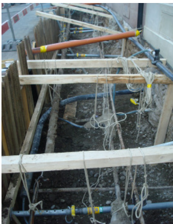
Bilder: Leitungsgaben mit neuen Leitungen und archäologischem Fund (eiserner Teuchelring)
