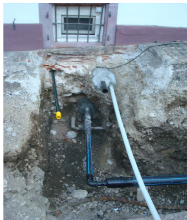
Bilder: Leitungsgaben mit neuen Leitungen und archäologischem Fund (eiserner Teuchelring)
